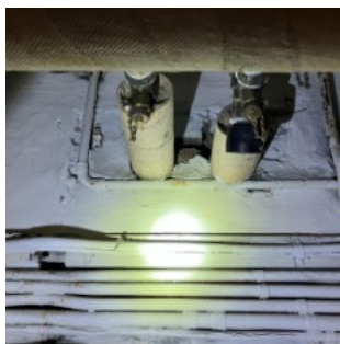
Kælder, Frederikssundsvej 317a
