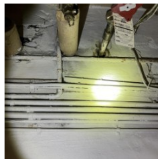
Kælder, Frederikssundsvej 317a
