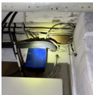
Kælder, Frederikssundsvej 319a
