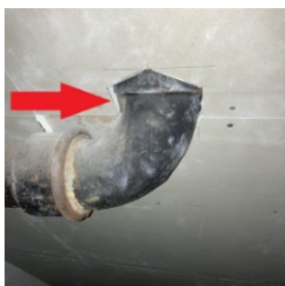
Tersløsevej 1, loft, brandkamserstatning mod Tersløsevej 3.
