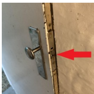
Glumsøvej 2, kælder, trapperum.
