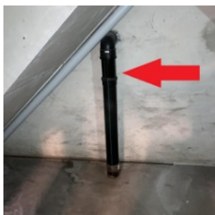
Tersløsevej 3, loft, brandvæg mod Tersløsevej 1, PVC-rør.
