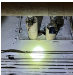
Kælder, Frederikssundsvej 317a
