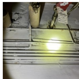
Kælder, Frederikssundsvej 317a
