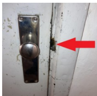
Glumsøvej 4, kælder, dør G04-00K.
