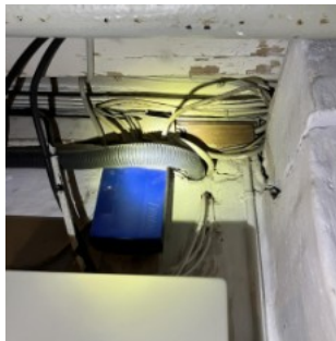
Kælder, Frederikssundsvej 319a
